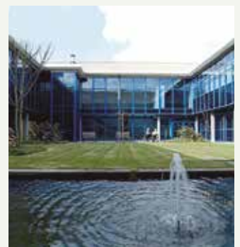
Canford House, Klinikgebäude des NHS. Bournemouth, Großbritannien. VRF
